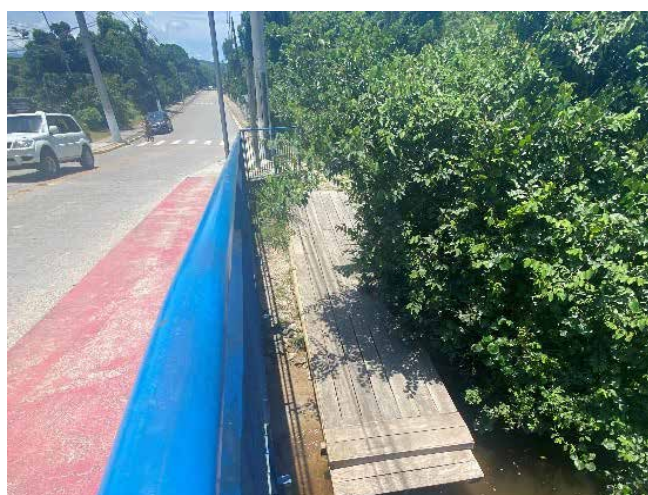
Figura 182 - Deck e píer junto ao Rio Sahy, em São Sebastião.
