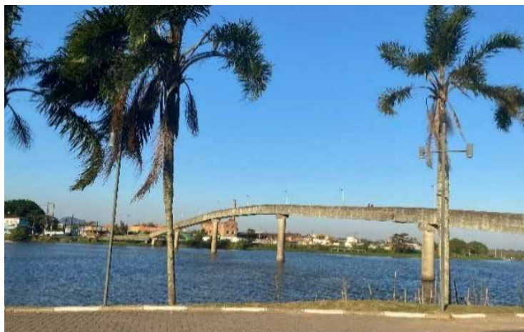
Figura 291 - Pontes sobre o canal de Iguape.
