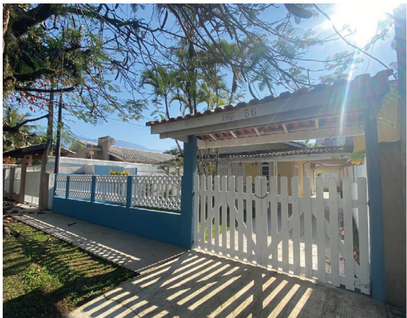
Figura 28 -Muros baixos e vazados na Praia de Capricórnio, em Caraguatatuba.
