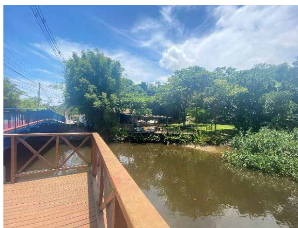
Figura 181 - Deck e píer junto ao Rio Sahy, em São Sebastião.
