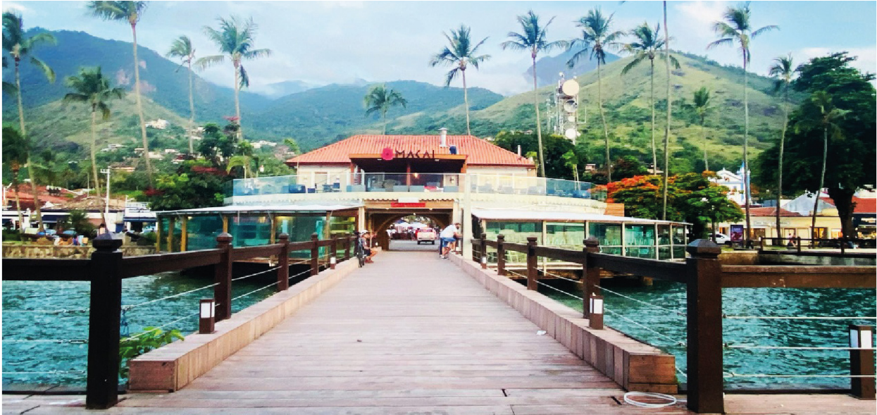
Figura 34-Pier no Centrinho, em Ilhabela.
