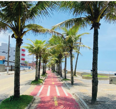
Figura 66- Ciclovia em Mongaguá.
