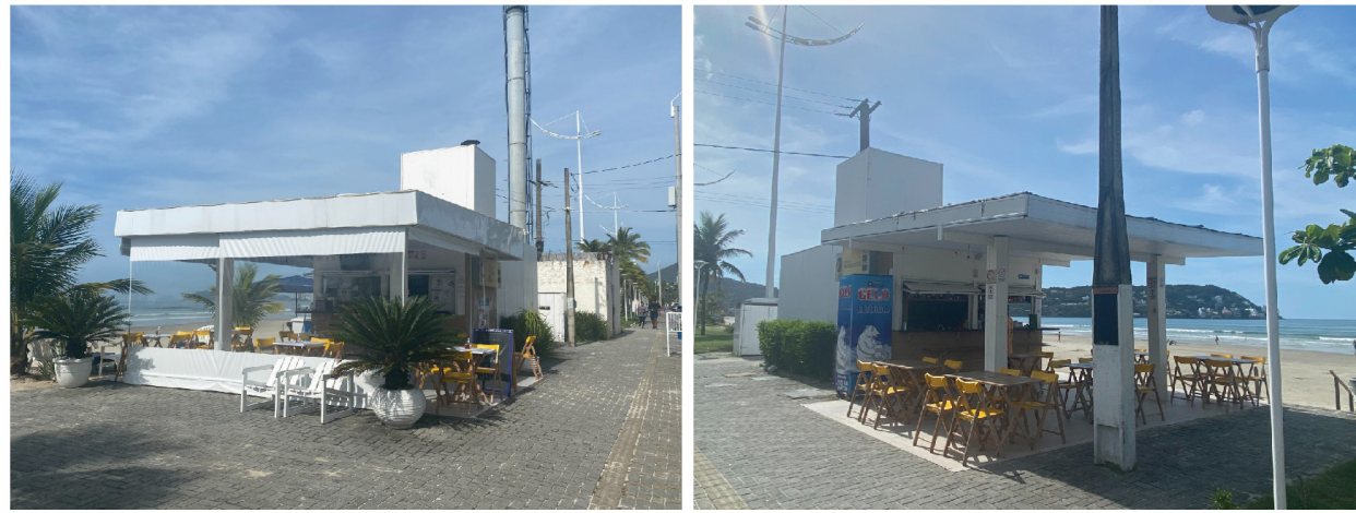
Figura 55-Padronização dos quiosques da Praia da Enseada, Guarujá.
