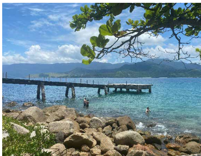
Figura 184 - Píer na Praia da Feiticeira, em Ilhabela.
