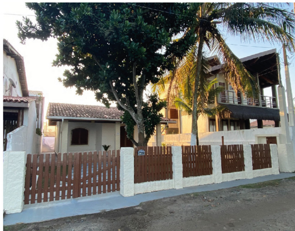
Figura 27 -Cercas baixas e vazadas na Praia de Capricórnio, em Caraguatatuba.
