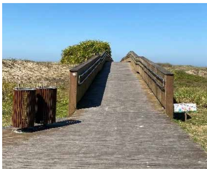
Figura 276 - Passarela com acesso ao mar na Praia de Monte Carlo, em Ilha Comprida.
