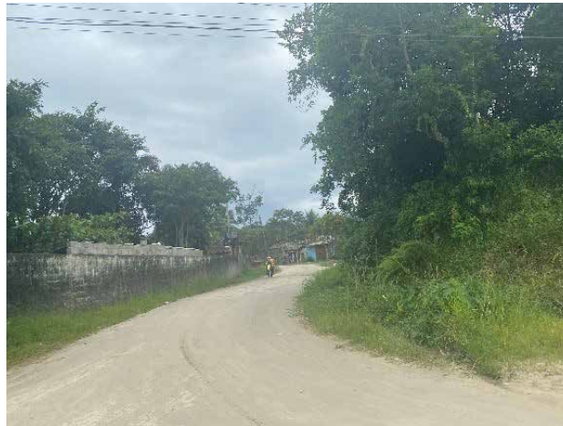
Figura 172 - Falta de infraestrutura urbana em Boracéia, São Sebastião.
