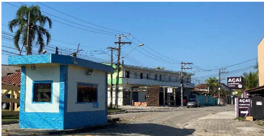
Figura 148 - Infraestrutura instalada e pouco adensamento construtivo e populacional no Condomínio Capricórnio, em Caraguatatuba.
