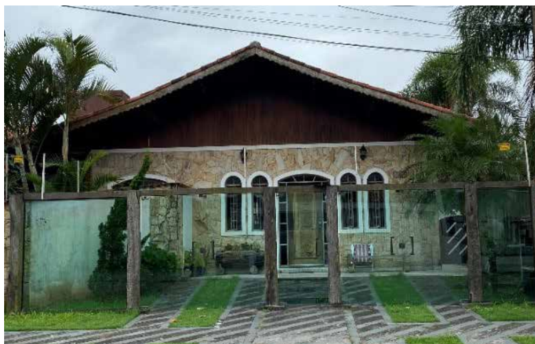
Figura 61 - Exemplo de permeabilidade visual na Praia de Cibratel II, em Itanhaém.
