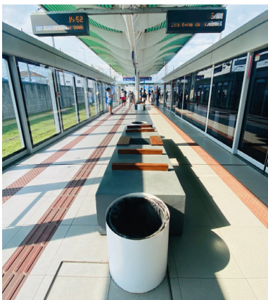
Figura 18-Vista interna da Estação do VLT.
