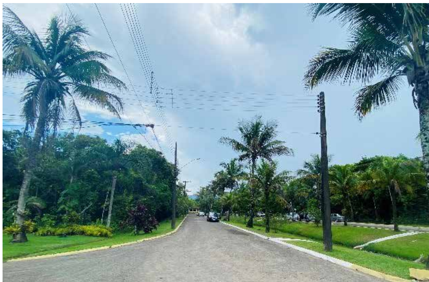
Figura 165 - Rua do Condomínio Amigos de Guaratuba, em Bertioga.
