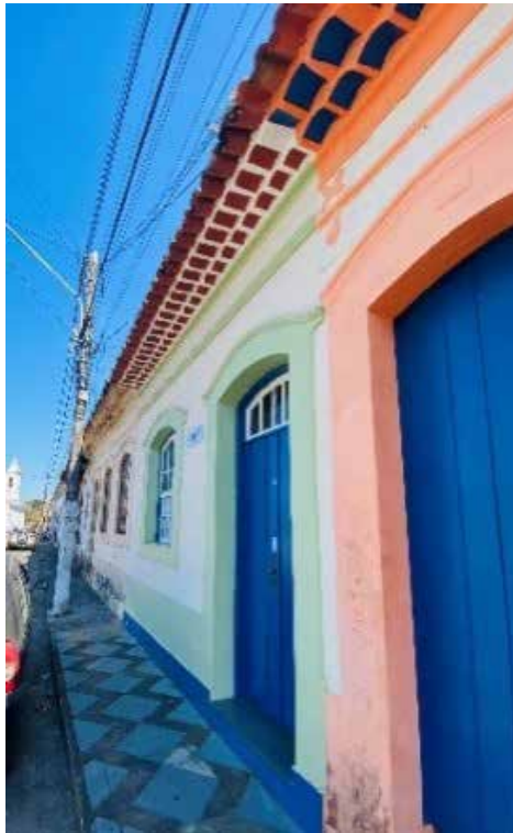
Figura 263 - Casario preservado no centro histórico de Iguape.
