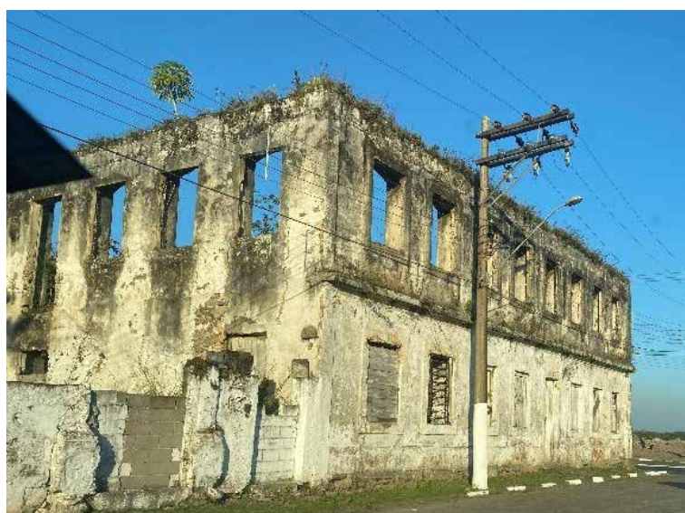
Figura 303 - Ruínas espalhadas pela cidade de Iguape.
