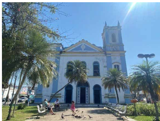
Figura 221 - Igreja Matriz no centro da cidade, em Ubatuba.
