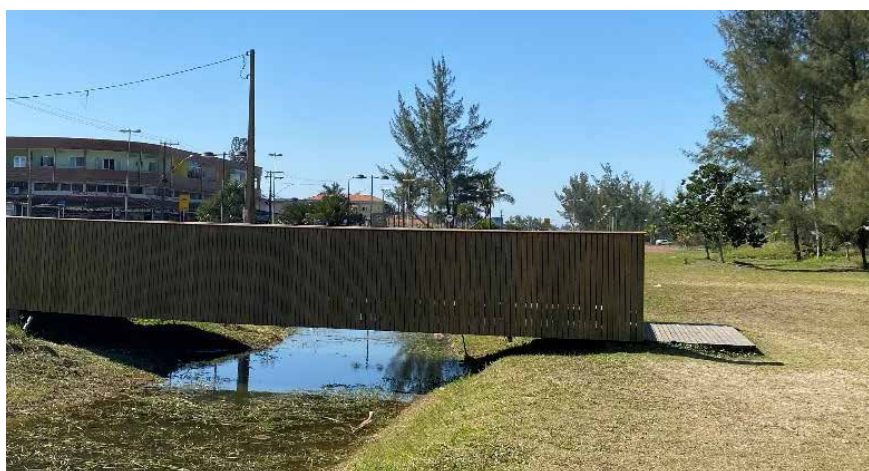
Figura 277 - Passarela com acesso ao mar na Praia de Monte Carlo, em Ilha Comprida.
