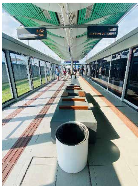
Figura 32 - Vista interna da Estação Bernardino de Campos.
