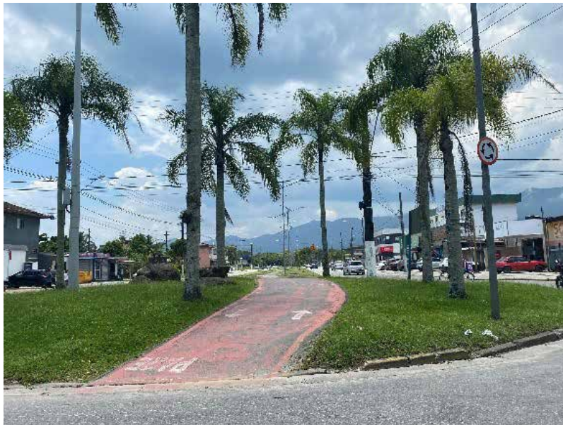
Figura 158 - Av. Anchieta com ciclovia e canteiro central.
