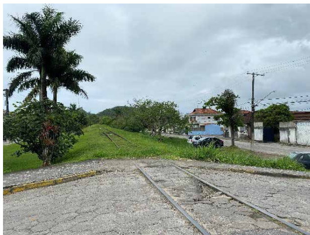
Figura 102 - Faixa de domínio da Fepasa na cidade de Itanhaém.
