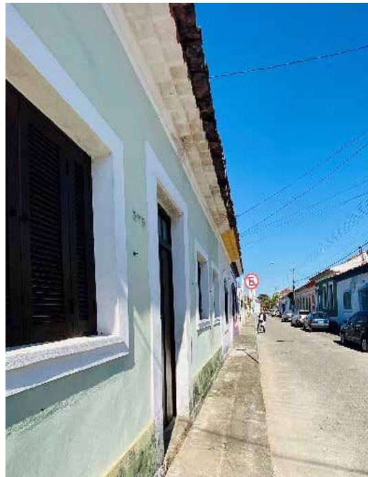
Figura 294 - Permeabilidade visual no centro histórico de Iguape.
