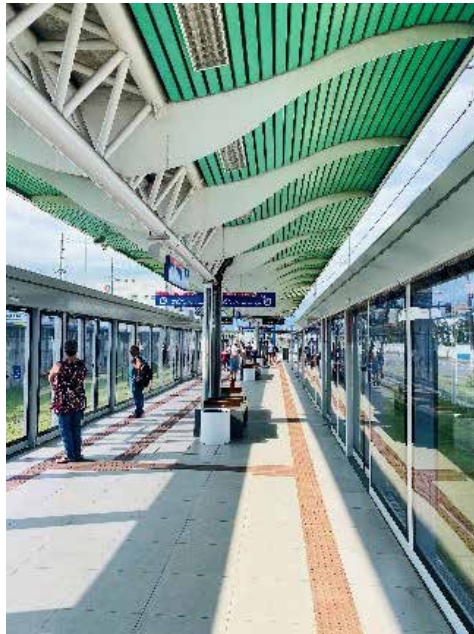
Figura 31 - Vista interna da Estação Bernardino de Campos.
