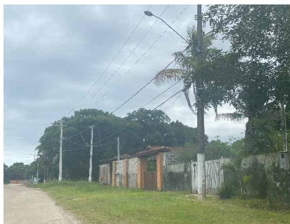
Figura 171 - Falta de infraestrutura urbana em Boracéia, São Sebastião.
