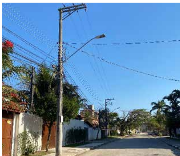
Figura 147 - Infraestrutura instalada e pouco adensamento construtivo e populacional no Condomínio Capricórnio, em Caraguatatuba.
