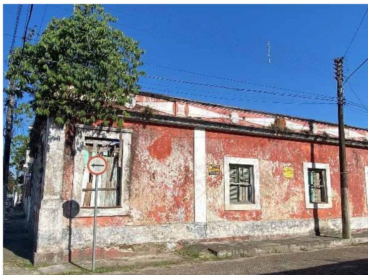
Figura 302 - Ruínas espalhadas pela cidade de Iguape.
