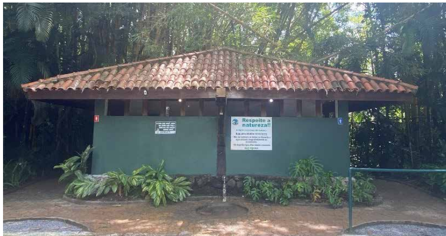
Figura 85 - Banheiros, chuveiros e estacionamento na Praia de São Pedro, no Guarujá.
