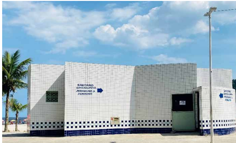
Figura 84 - Banheiros na Praia do Gonzaguinha em São Vicente.
