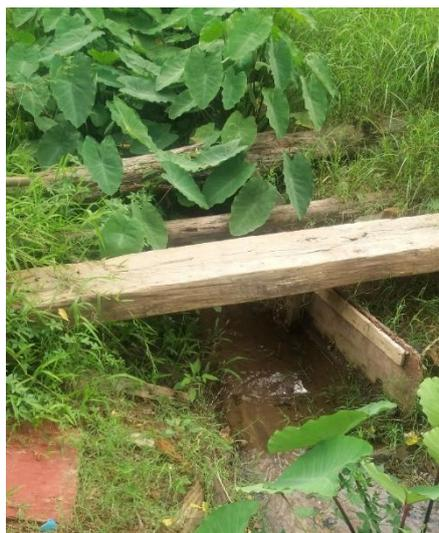
Figura 10: Foto de passagem de pedestres sobre canal de escoamento pluvial feita de forma insegura no Banhado. Fonte: foto tirada pela equipe de projeto em 16/03/2019.
