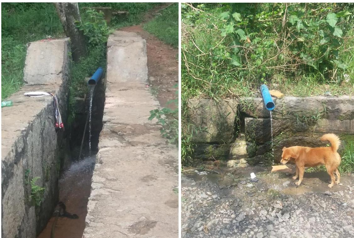
Figura 2: Fotos da canalização de águas que afloram na encosta e são utilizadas pela população para banho e consumo. Fonte: fotos tiradas pela equipe de projeto em 16/03/2019.
