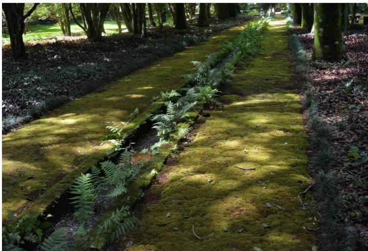
Figura 7: Estrutura de disciplinamento de água em canal com vegetação no leito, localizada na Fazenda Conde do Pinhal em São Carlos/SP. Fonte: foto tirada pela equipe de projeto em 07/02/2019.
