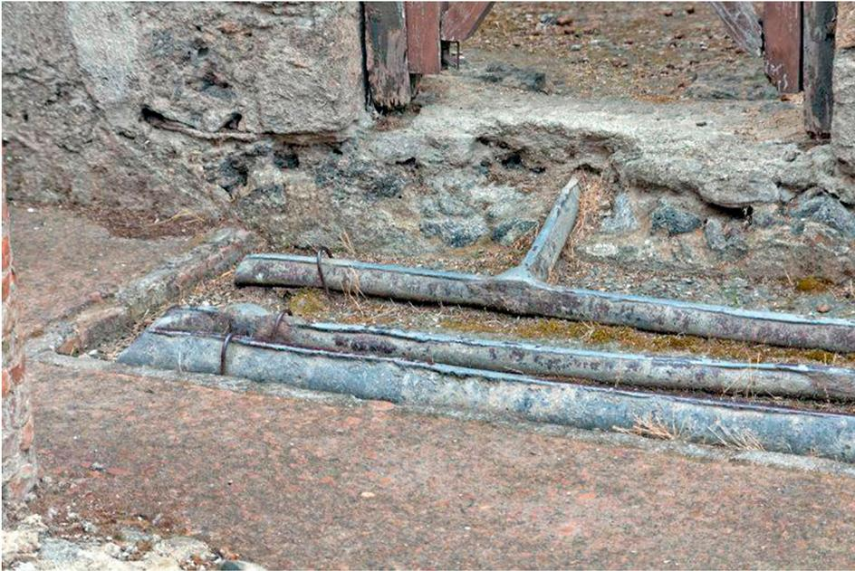
Fig. 13. Tubulação de água em chumbo para abastecimento, localizado no Cardo IV, em frente à Casa de Netuno e Anfitrite. Disponível em: <https://i.pinimg.com/originals/e4/e6/78/e4e67876af84b8a1774d35d61103c62d.jpg> Acesso em: jan/2019.
