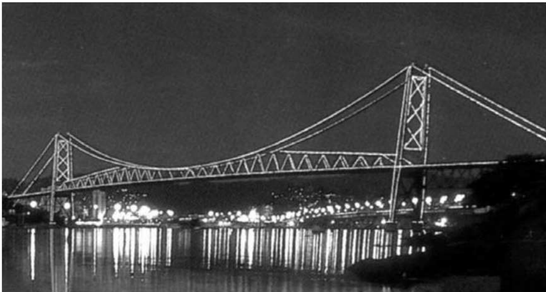
Figura 1. Aspecto general de un puente tipo colgante.
