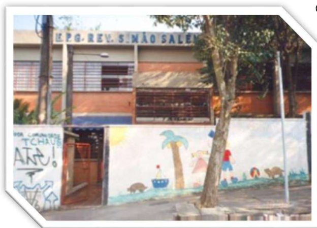
Figura 16 – Instalações da escola estadual Reverendo Simão Salem (2002)
