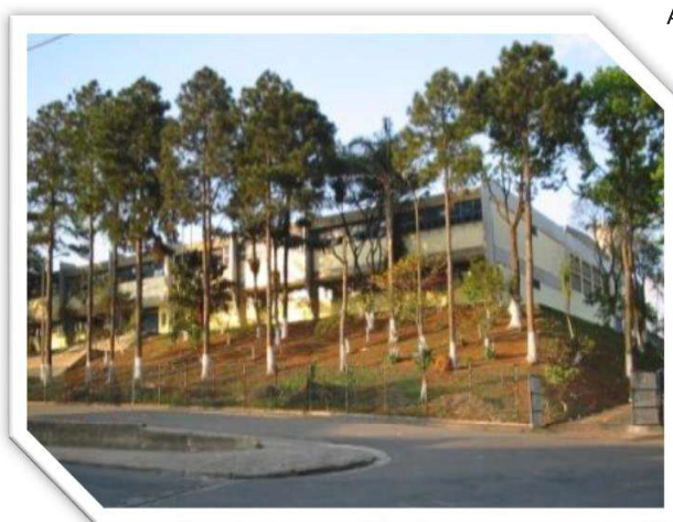
Figura 18 – Instalações da escola estadual Pe. Agnaldo Sebastião Vieira (2002)
