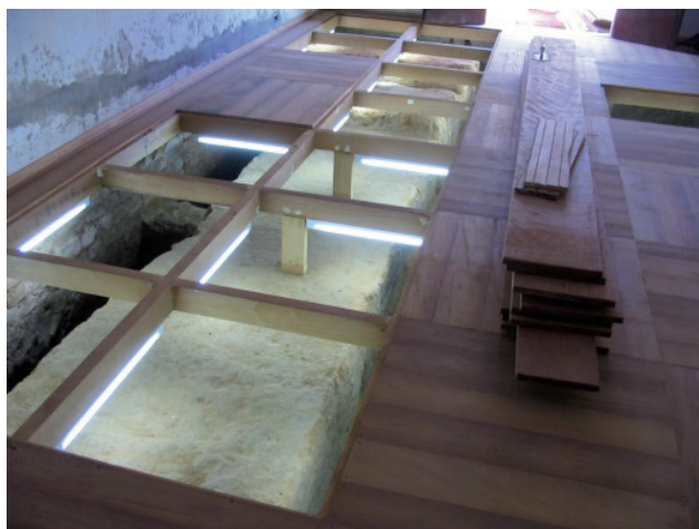
Construção de tijolo da capela atual sobre as estruturas de taipa do antigo aldeamento e vista no interior da capela mostrando as paredes de taipa sob o piso atual
