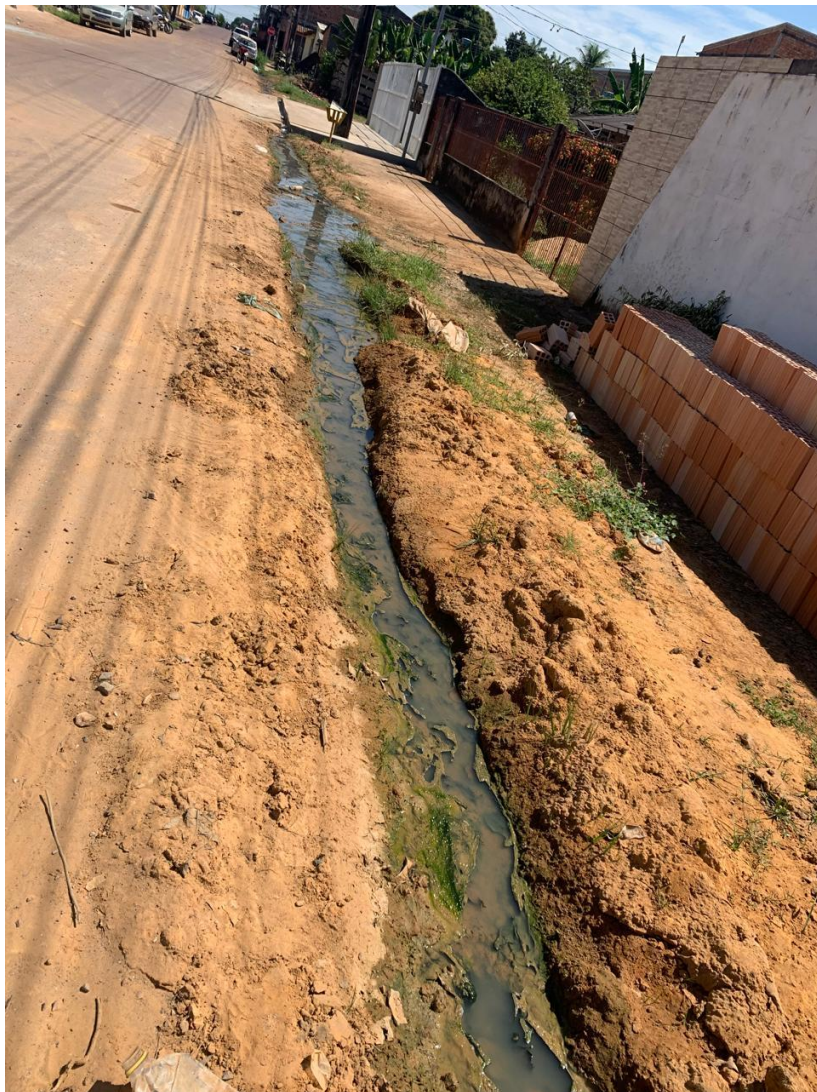
Figura 1: Galeria de esgoto a céu aberto em rua no centro de Itaituba, PA
